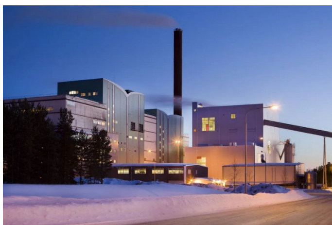
Figur 13. Dava Kraftvärmeverk. Foto: Umeå Energi.
