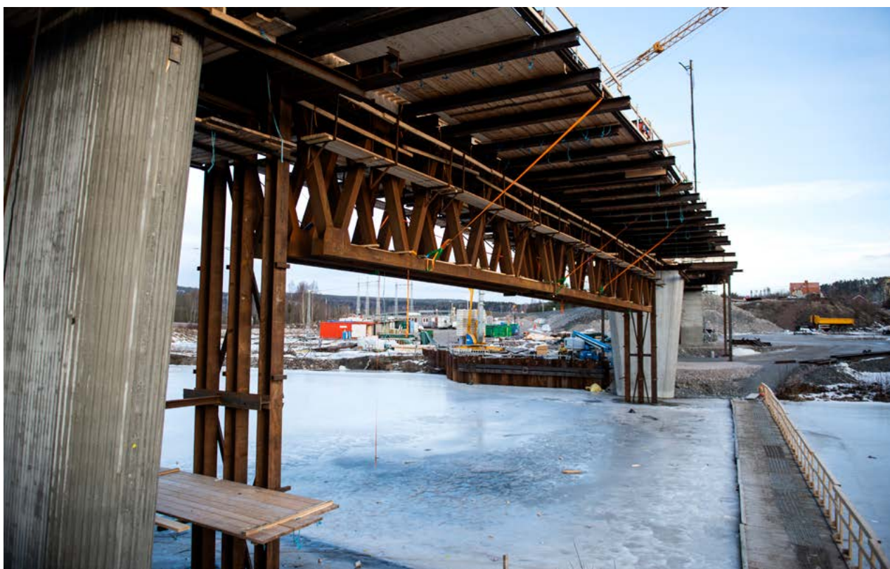
Gjutning av bro, Sundsvall.
