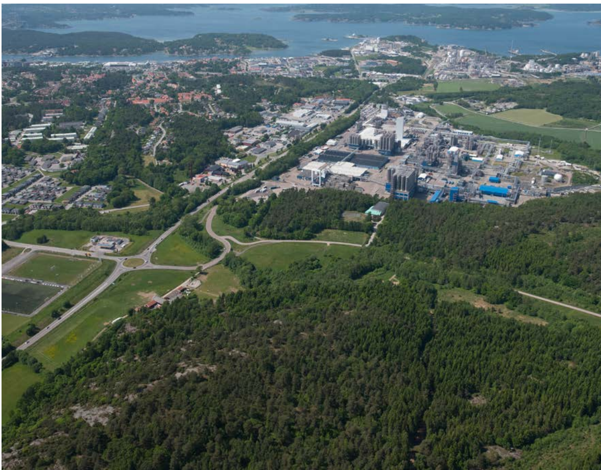
Sveriges första anläggning för kemisk återvinning i Stenungssund beräknas vara i drift 2025.
