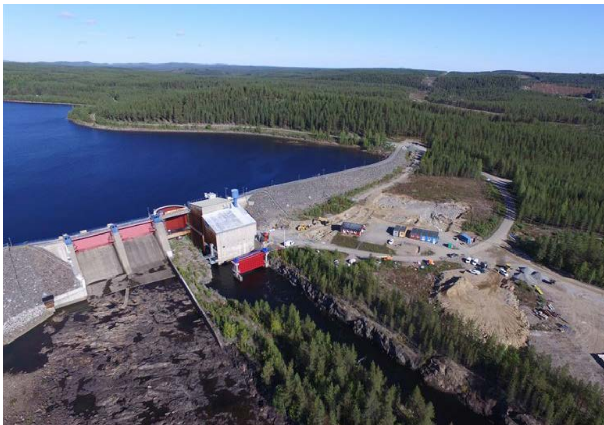
Effekten fördubblas från 35 till 70 MW i vattenkraftverket Rengård i Skellefteälven.
