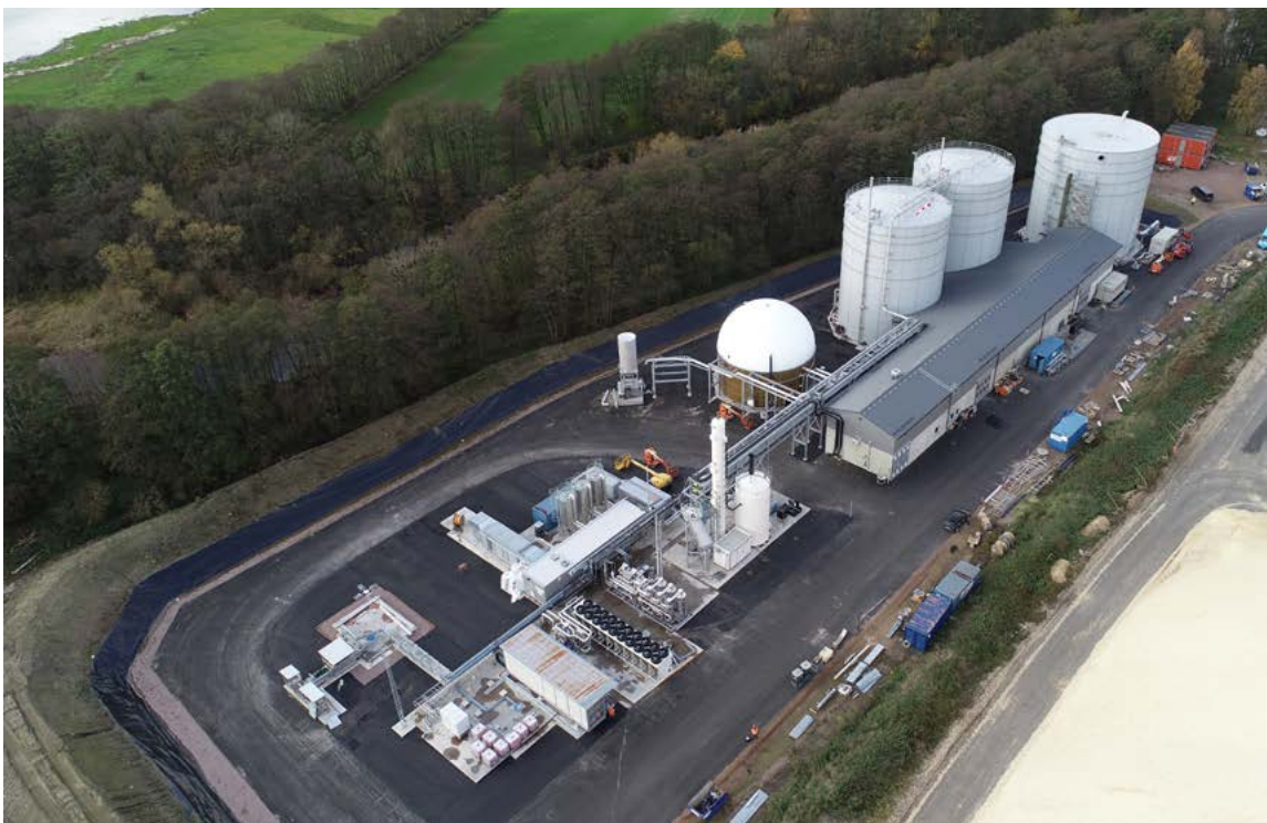
Gasums biogasanläggning i Nymölla, den första i Sverige som producerar flytande biogas av processvatten från Stora Enso's massa- och pappersbruk.
