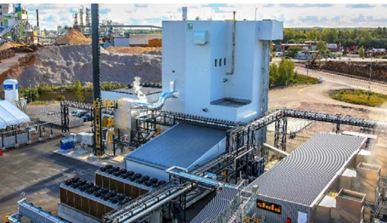
I Preems produktionsanläggning Pyrocell i Gävle omvandlas sågspån till icke-fossil pyrolysolja.
