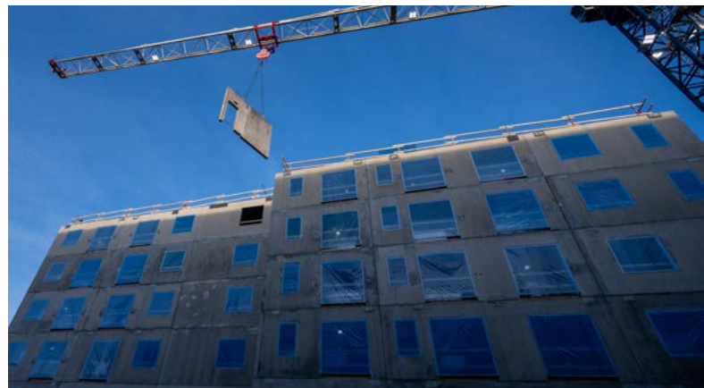
Betong med skalaska i bostadsprojektet Sege park i Malmö ger upp till en halverad klimatpåverkan.
