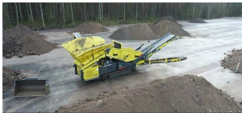
Överskottsmassor i Sälgsjöns bergtäkt sorteras i ett hybridverk som kan drivas på el.
